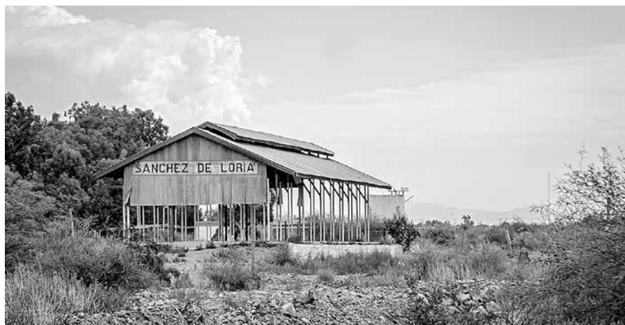
La casilla del ferrocarril de la antigua estación Sánchez de Loria, al costado oeste de calle Lemos entre calles 7 y 8, permanece como silencioso testigo del paso del tiempo y de una época marcada por el movimiento del tren y la vida rural.
