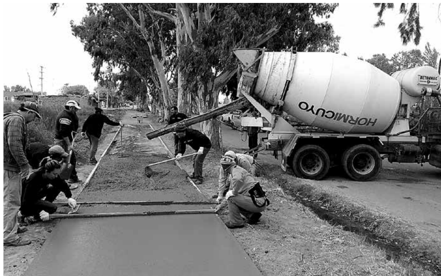
Vecinos trabajando en la construcción de veredas, acompañando el crecimiento de la zona y dejando, paso a paso, huellas de esfuerzo y progreso compartido.
